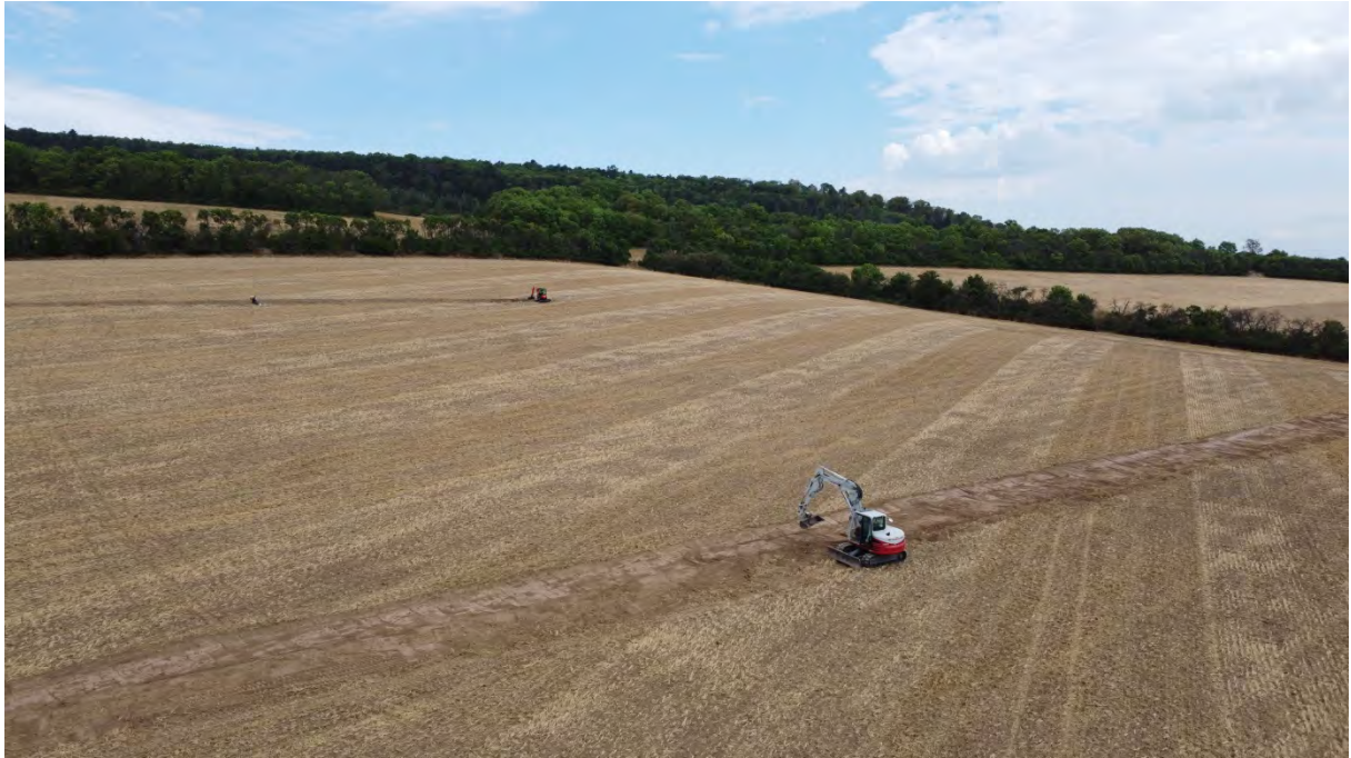
Abbildung 3: Anlage der Retentionsgräben am 05.08.2022.
